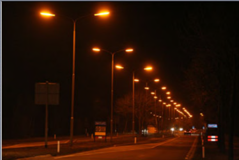
Oude installatie met SOX - veel strooilicht
